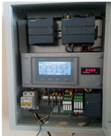
Рисунок 5. Блок промышленного контроллера, управляющего работой системы светодиодного освещения этажа университета
