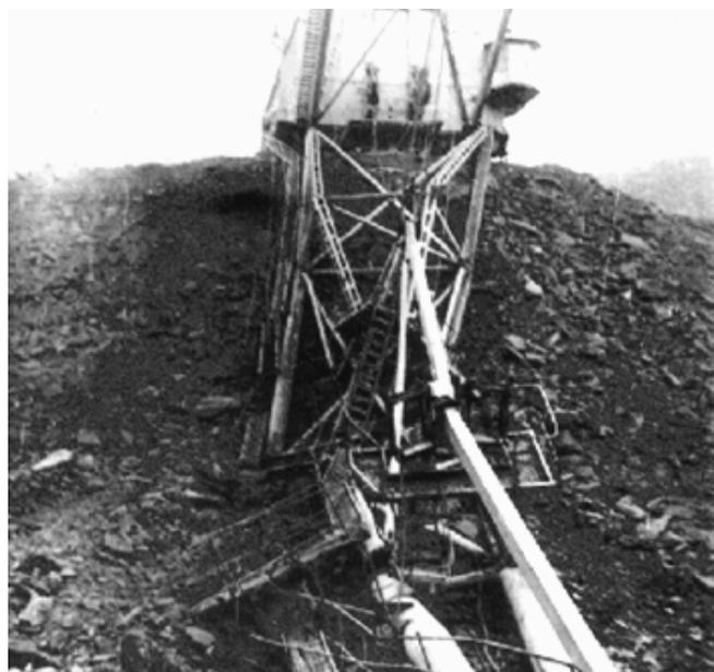
Рис. 1. Примеры разрушений техники в условиях Сибири и Крайнего Севера. Наверху – разрушение козлового крана грузоподъемностью 10 тс при  $-32^{\circ}\text{C}$  (2002 г.); посередине – разрушение газопровода Матах–Берге–Якутск при  $-50^{\circ}\text{C}$  (протяженность разрушения – 3,3 км, диаметр трубы – 530 мм, давление 35 ат, 1987 г.); внизу – разрушение стрелы шагающего экскаватора ЭШ-10/70 при  $-30^{\circ}\text{C}$  (1992 г., Красноярский край)
